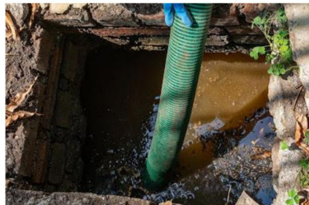
Desludging first chamber of ABR unit
