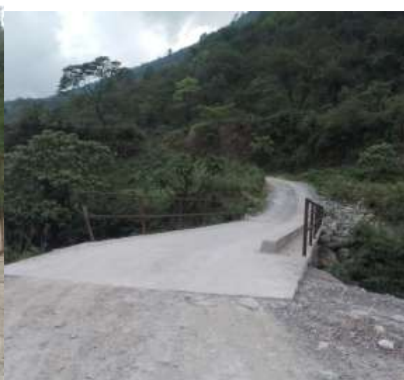
फोटो २: भलौदी खोलामा पुल निर्माणमा सहयोग
