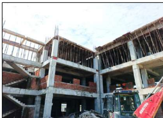
सिद्धिविनायक मा.वि., भरतपुर म.न.पा. ११, चितवनमा बौद्धिक अपाङ्गता भएका बालबालिकाहरुका लागि भवन निर्माण
