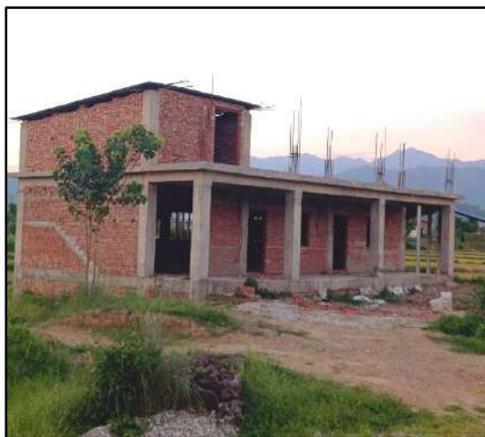
पिपरा टोल विकास संस्थाको सामुदायिक भवन निर्माण खैरहनी ९ चितवन
