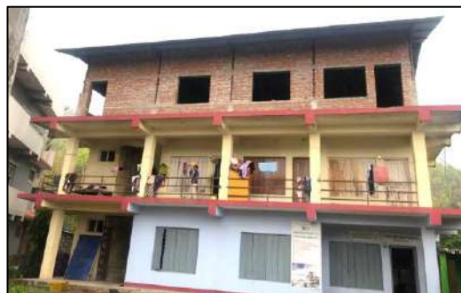
सार्वजनिक पुस्तकालय भवन निर्माण, मनहरी ७, मकवानपुर
