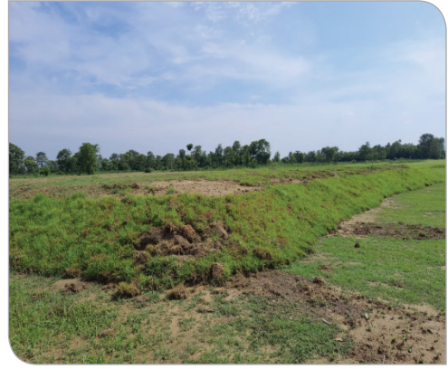
कृष्णसारको लागि उच्चथलो (माउण्ट) निर्माण, कृष्णसार स.क्षे.
