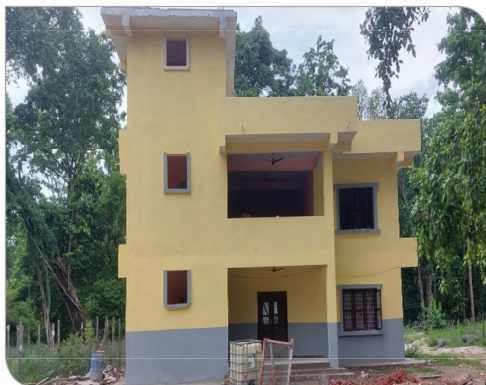
रेन्जर आवास भवन, पर्सा रा.नि.
