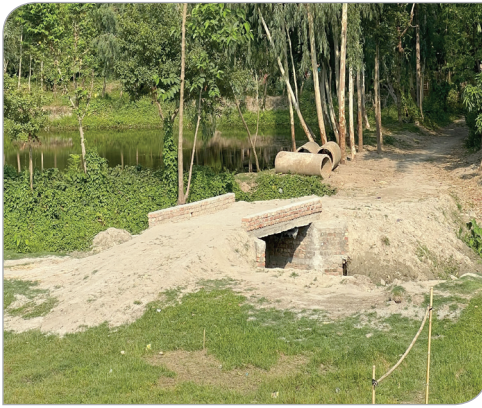
कल्भर्ट निर्माण, कोशीटप्पु व. आ.
