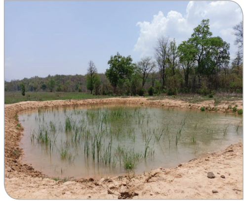
पानि पोखरी निर्माण, बाँके रा.नि.
