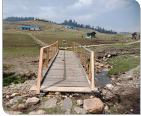
काठे पूल निर्माण, खप्तड रा.नि.
