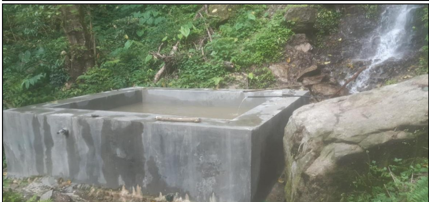
गंगाखोला सामुदायिक वनमा पानी मुहान संरक्षण संरचना निर्माण, रामप्रसादराई गा.पा.६, संरचना निर्माण: २ वटा, लाभान्वित संख्या: १५ घरधुरी
