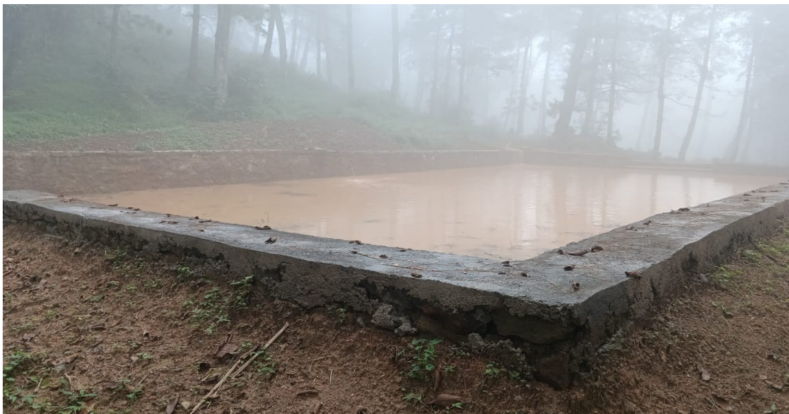
भकिम्ले सामुदायिक वनमा संरक्षण तथा पुनर्भरण पोखरी निर्माण, भोजपुर न.पा.९ जलसंचित क्षमता: ३१६ घ.मि., वृक्षारोपण: ३०० विरुवा, ट्रेल सिँढी: ८ मिटर
