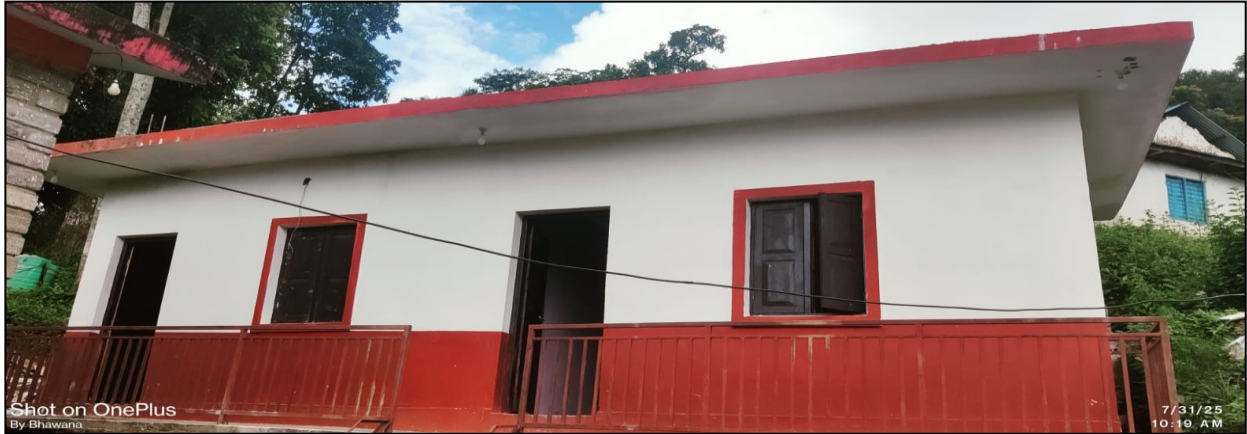
सब डिभिजन वन कार्यालय, दिङ्गला, भोजपुरमा निर्माण गरिएको कार्यालय भवन
